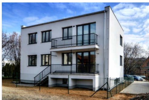
Novostavba se 3 byty, Bílovice n. Svitavou
